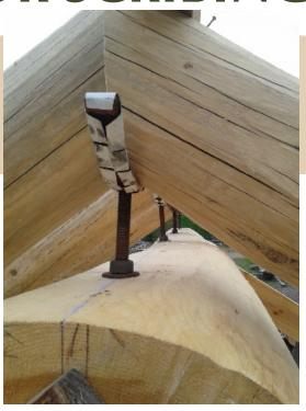
BROKEN SAW BLADE SHIM
